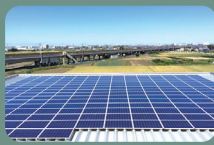
市民発電所第1号(黒崎市民会館)
